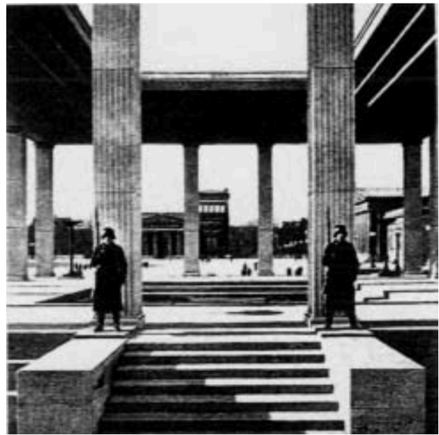
Escalier extérieur menant au temple d'honneur avec garde d'honneur.
